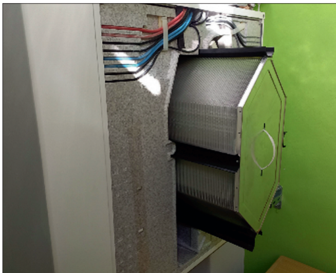
▲ Obr. 4 ● Rekuperační výměník
